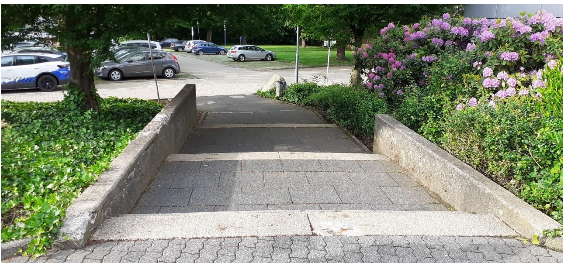
Abbildung 75: Treppenanlage Parkplatz Rathaus
