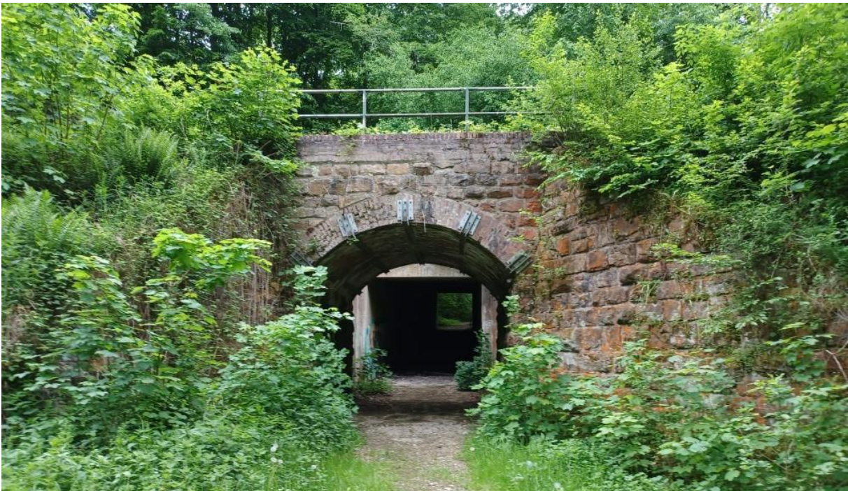
Abbildung 31: Brücke über Waldweg
