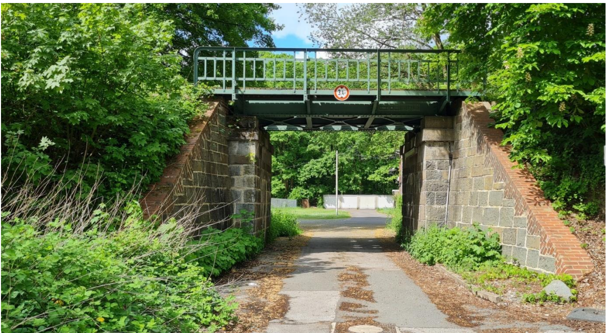
Abbildung 19: Eisenbahnüberführung Öhder Straße
