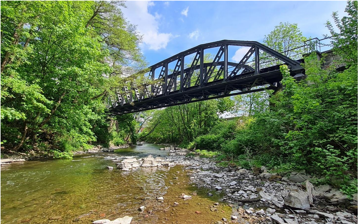
Abbildung 18: Eisenbahnbrücke über die Wupper bei Öhde
