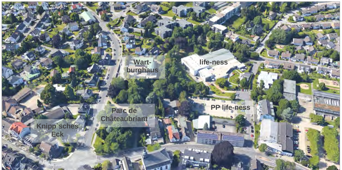
Abbildung 49: Luftbildaufnahme Lupenraum Nord
